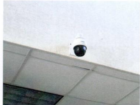
Biblioteca ubicada en el pasillo
