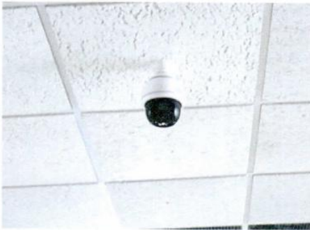
Laboratorio Pesado 1 pasillo
